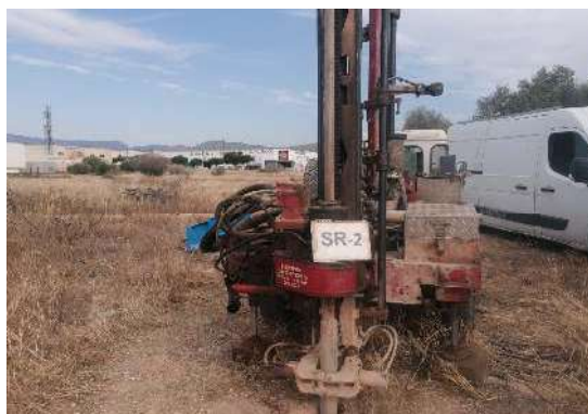
Fotografía 5: Vista de la sonda durante la ejecución del sondeo S-2
