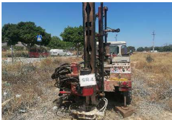
Fotografía 13: Vista de la sonda durante la ejecución del sondeo S-4
