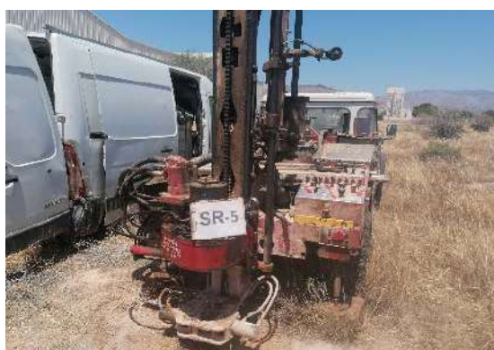
Fotografía 17: Vista de la sonda durante la ejecución del sondeo S-5
