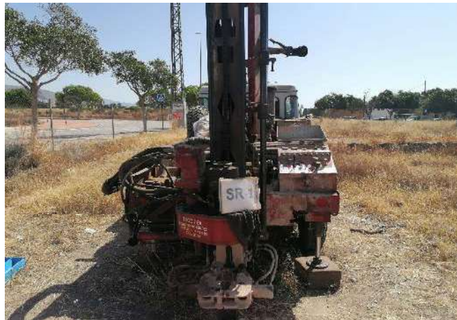
Fotografía 1: Vista de la sonda durante la realización del Sondeo S-1
